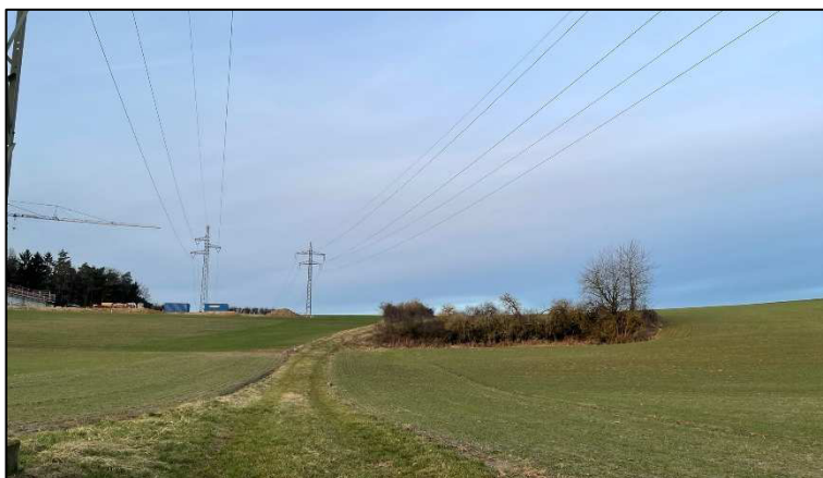
Blick vom Osten nach Norden. 110kV-Freileitungen überspannen das Gebiet.
