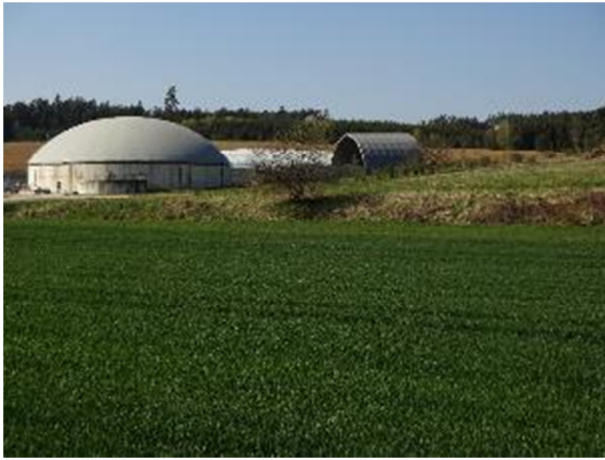
Blick ausgehend von der Kreisstraße auf die westlich bestehende Biogasanlage sowie das Planungsgebiet
