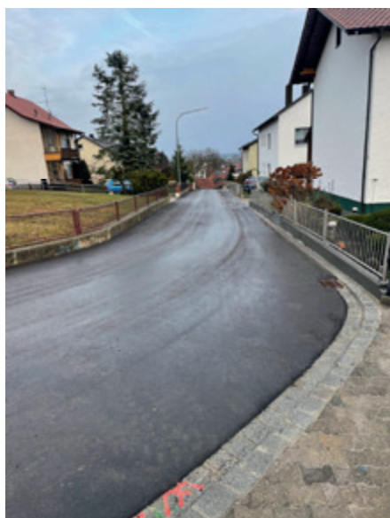
Die Sanierung der Gartenstraße in Pfaffenberg ist abgeschlossen
