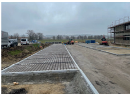
Die Parkplätze werden angelegt.
