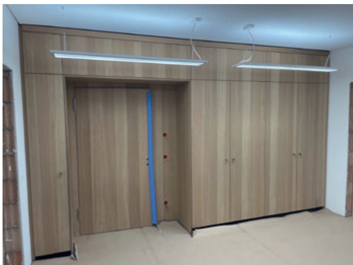
Die Büros erhalten moderne Schrankwände.
