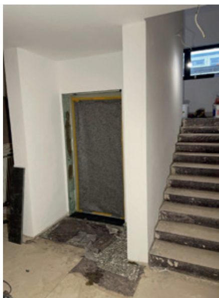
Aufzug in der St. Martin-Schule
