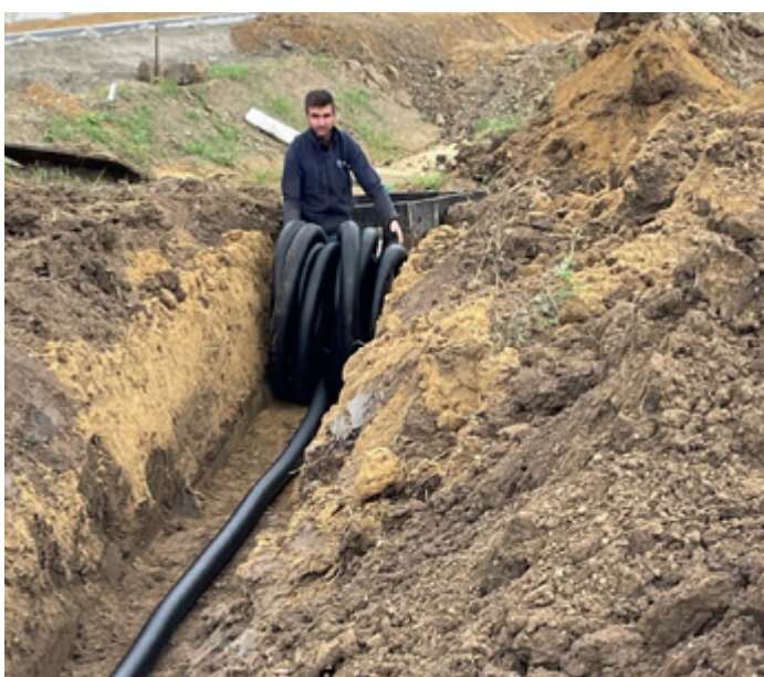
Versorgungsleitungen werden verlegt.
