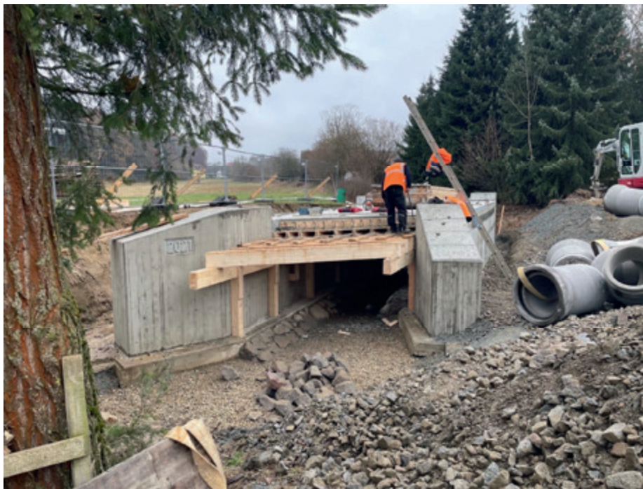
Brückenneubau in Unterellenbach
