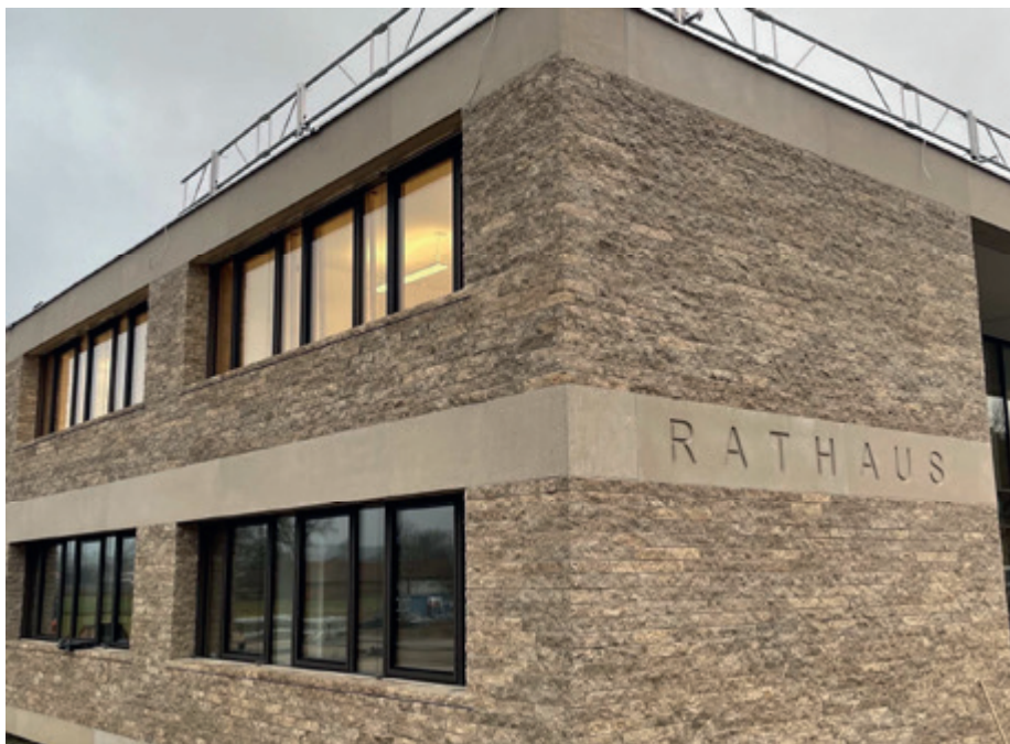
Die Außenfassade ist bereits fertig.
