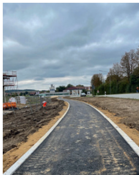
Der neu angelegte Gehweg.
