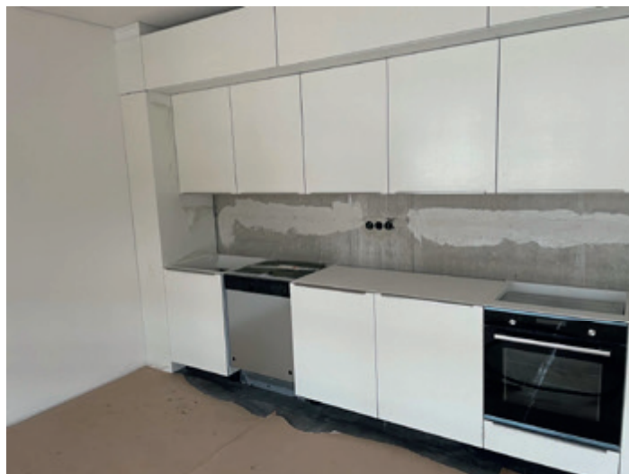
Die Installation der Teeküche ist bereits weit fortgeschritten.
