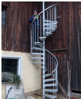
Hier bietet eine Wendeltreppe einen sicheren Aufstieg.
